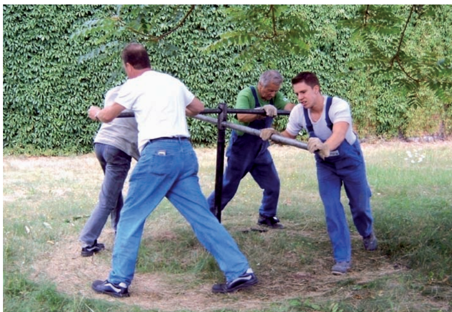
Bild 1: Mitarbeiter der Berliner Wasserbetriebe beim Schließen eines DN 700 er Verbindungsschieber mit 74 Gang
