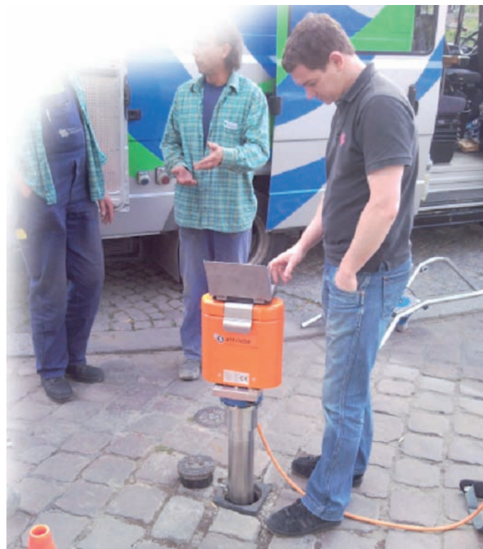
Bild 3: Inspektion/Wartung eines Schiebers DN 600 mit dem System Berliner Kappe®
